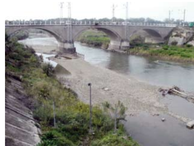
Железнодорожный мост через Уруп, построенный в 1947 году. Рядом с ним (перед ним) стоял транспортный мост, снесённый дважды: в 1952 году и в 2002 году.
